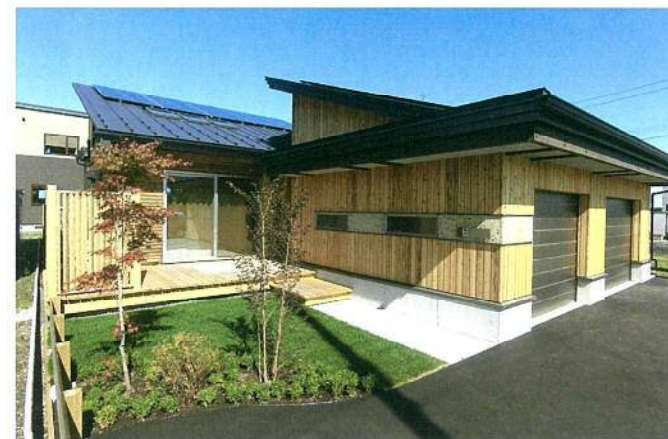
内外装ともに自然素材を多用。北海道産木材もよく利用する
